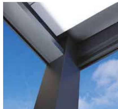
Drenaje directo en el poste lateral a través del canalón
