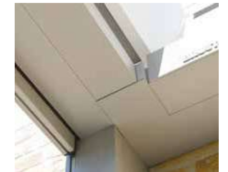
Drenaje directo en el poste lateral a través del canalón
